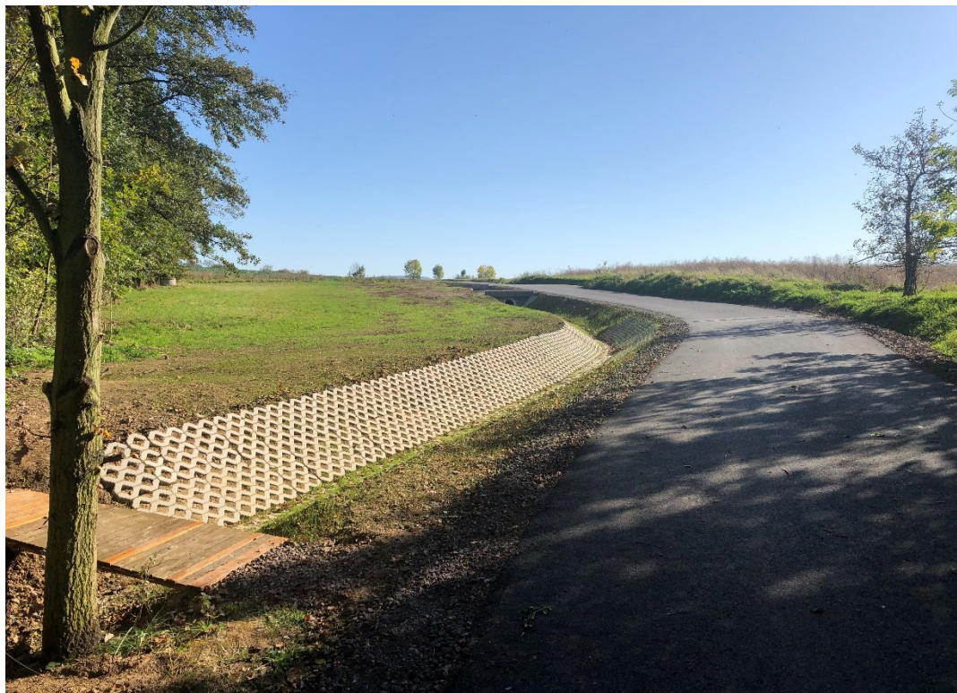
Rekonstrukce polní cesty v k.ú. Kotopeky včetně odvodňovacího příkopu (včetně zajištění ochrany obce před přívalovými srážkami)
