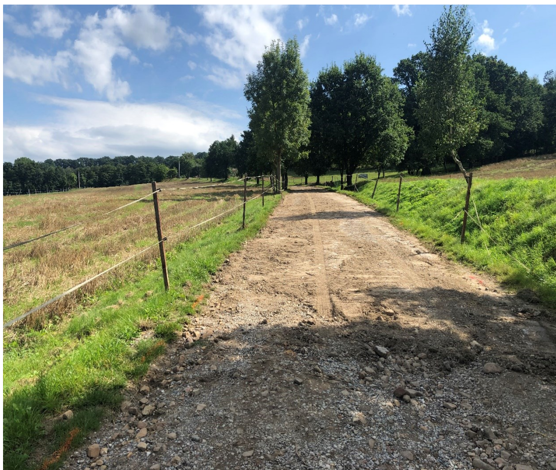
Rekonstrukce polní cesty v k.ú. Svinaře – před započítím stavby
