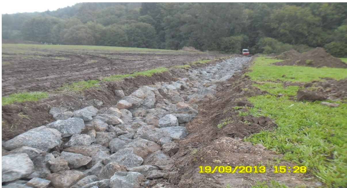
Stavba záchytného příkopu v k.ú. Svatá
