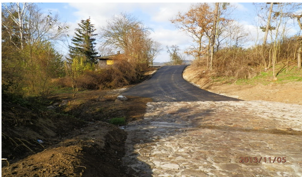
Rekonstrukce brodu v k.ú. Chodouň, včetně navazujících polních cest
