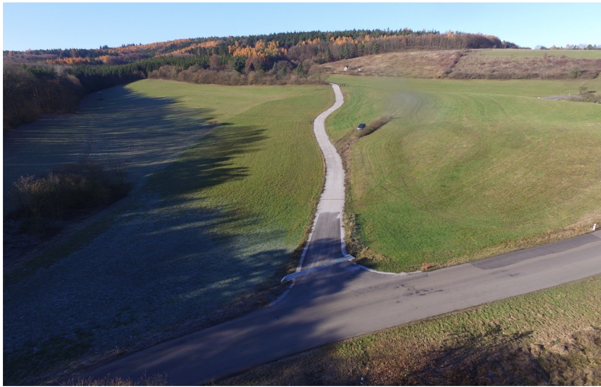
Rekonstrukce polní cesty v k.ú. Svata – po provedení stavebních prací
