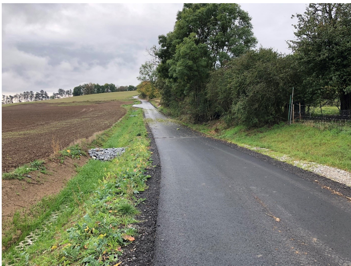
Rekonstrukce polní cesty a odvodňovací příkop v k.ú. Trubská
